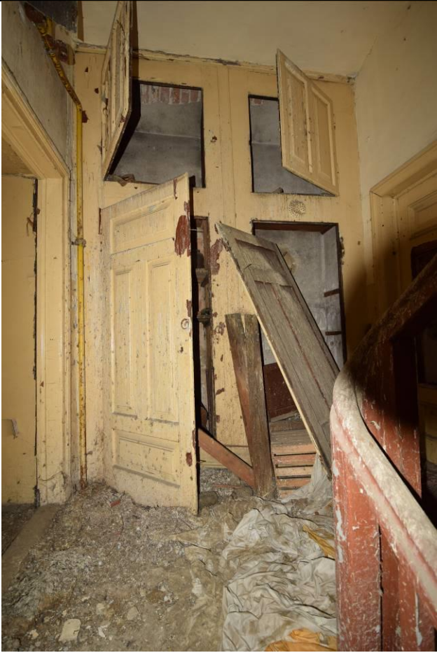
Szafa wnekowa na klatce schodowej oficyny.
