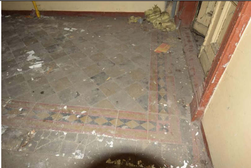
Dekoracja posadzki głównej klatki schodowej.
