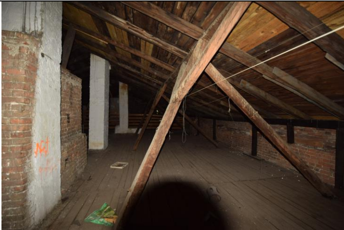
Poddasze. Więźba płatwiowa o stolcach kozłowych.
