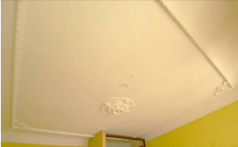
Dekoracja stiukowa sufitu zachowana w jednym z mieszkań korpusu głównego.
