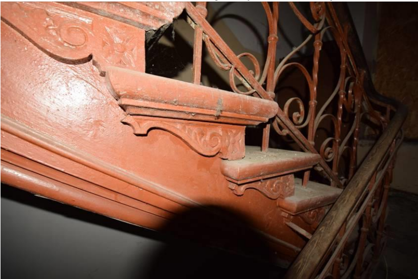
Dekoracyjne policzki schodów głównej klatki schodowej.
