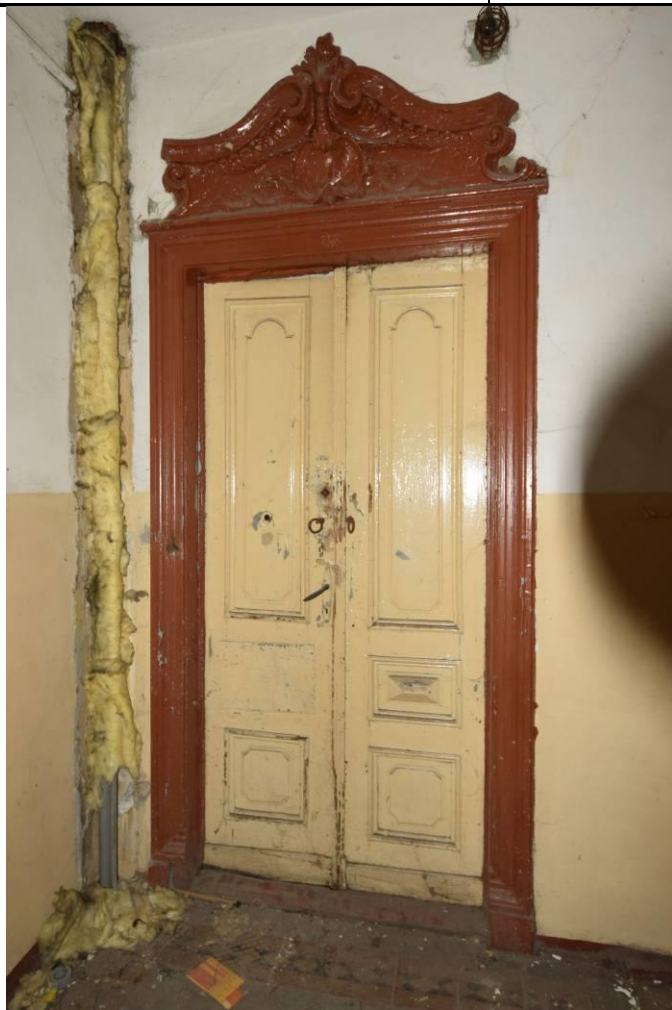
Drzwi wejściowe do jednego z mieszkań na głównej klatce schodowej.
